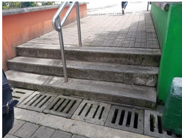
Fotografía No.2. Rejilla del Parque principal Santa Bárbara, se evidencia la diferencia en la estandarización de las rejillas, la cuales presentan espacios, diferencia de tamaños y regularidad.
