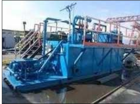
Imagen 4. Tanque de reserva
