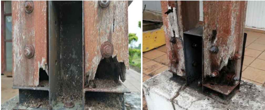
IMÁGENES 3 Y 4, DIAGNÓSTICO - ESTADO REJILLAS CONCRETO Y CERRAMIENTO MUROS MADERA EXTERNA FUENTE: CONSULTORÍA
