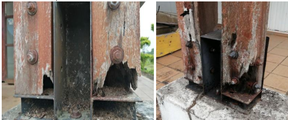
IMÁGENES 1 Y 2, DIAGNÓSTICO - ESTADO ESTRUCTURA MADERA EXTERNA. FUENTE: CONSULTORÍA
