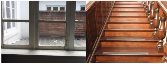
FIGURA 4 ESTADO ACTUAL DE CARPINTERÍAS DE MADERA.
