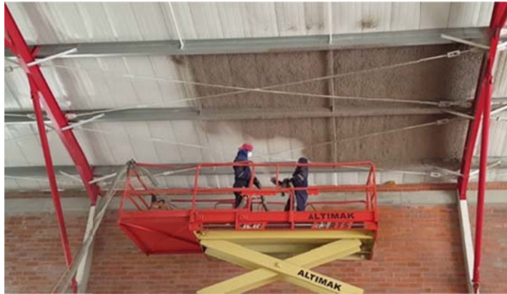
Muestra del acabado superficial de la celulosa proyectada de 1" de espesor.
