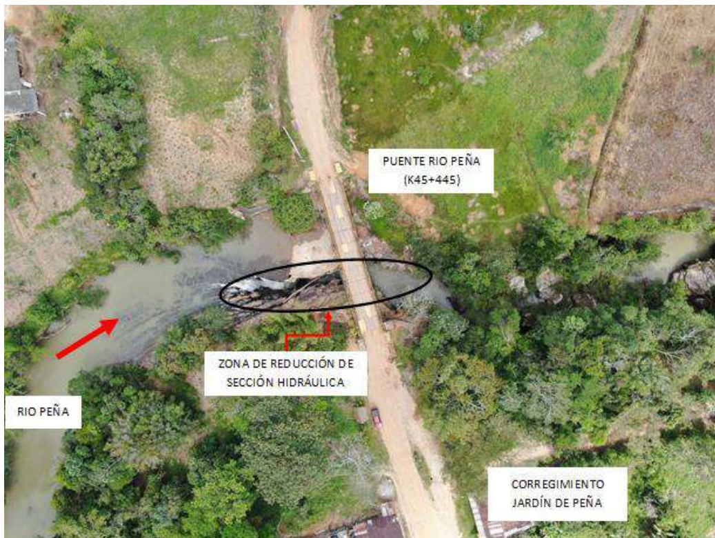
Figura 4. Ortofoto del sitio de implantación del Puente Rio Peña. En el círculo se señala la reducción hidráulica que presenta el río
