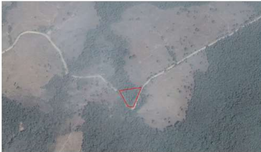
Figura 10. Localización del Puente en el K25+600. Fuente: Google Earth.
