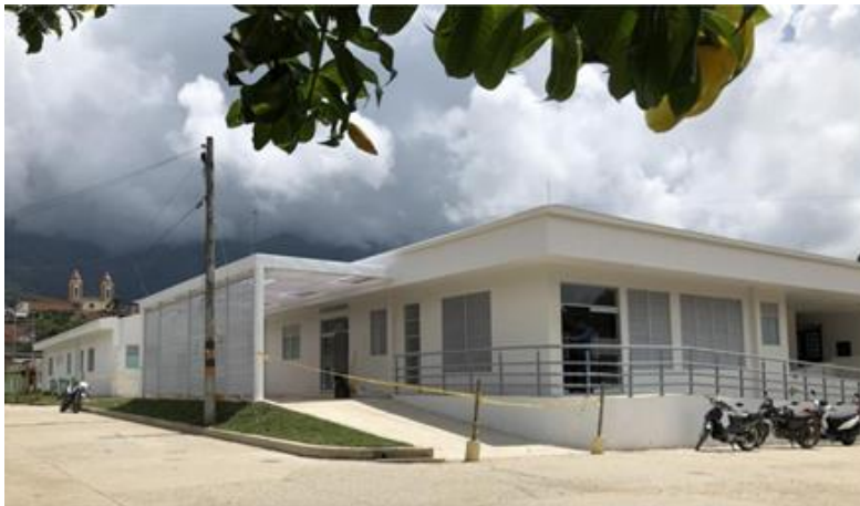
Ilustración 12 Proyecto Remodelación, Adecuación y Ampliación de la Infraestructura del “Hospital la Misericordia E.S.E.”
