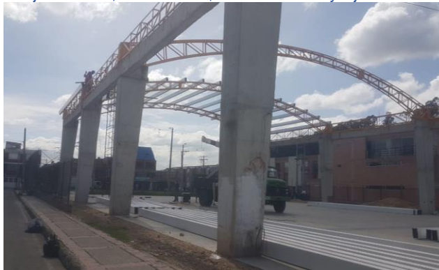
Ilustración 8 Proyecto: Mejoramiento, Adecuación, Remodelación y Ajustes a Diseños de Polideportivos
