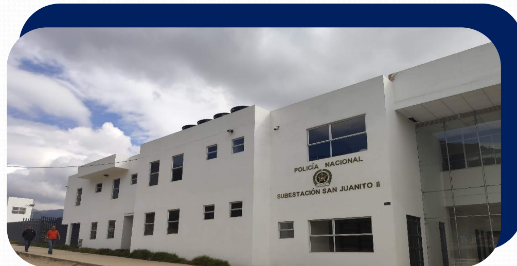
Ilustración 3 Subestación de Policía San Juanito II
