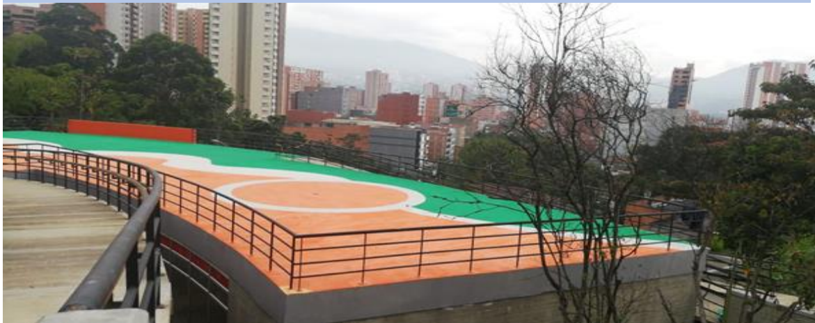
Ilustración 11 Construcción corredor juvenil
