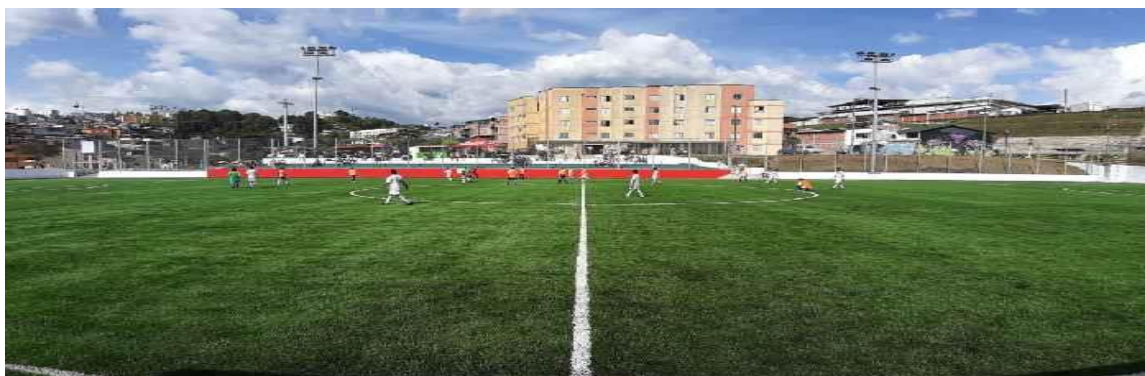
Ilustración 12 Construcción y adecuación de cancha en el barrio Arrayanes
