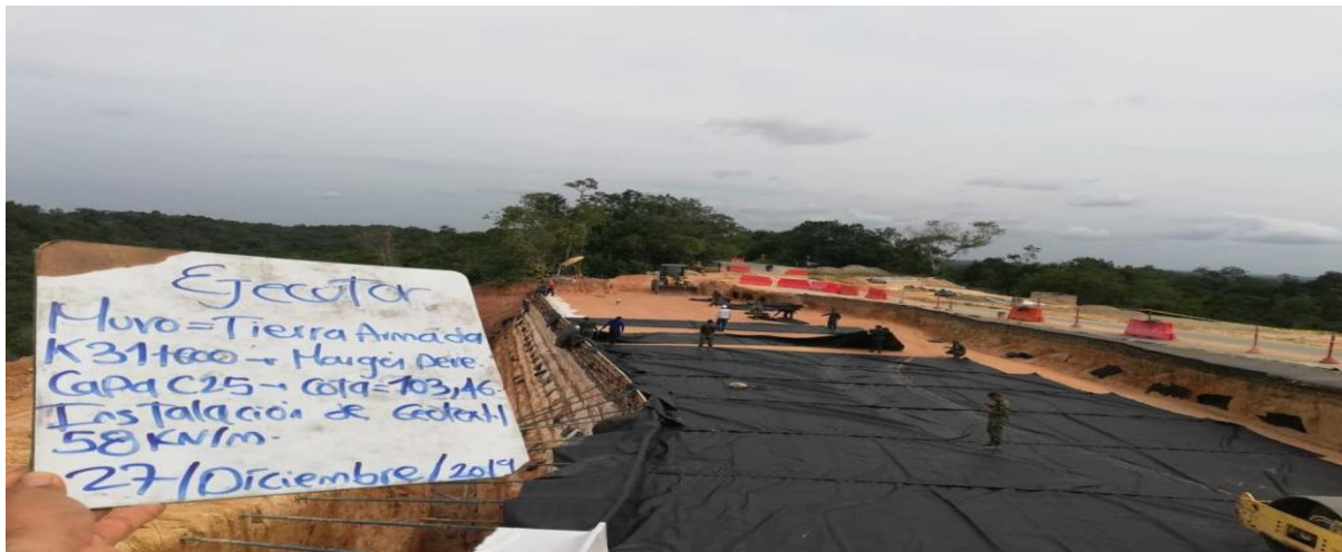
Ilustración 15 Tibú la Gabarra – muro en suelo reforzado K31+600MD
