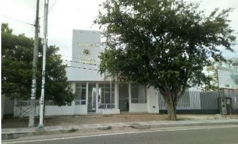
Ilustración 2 Estación de policía Hatonuevo
