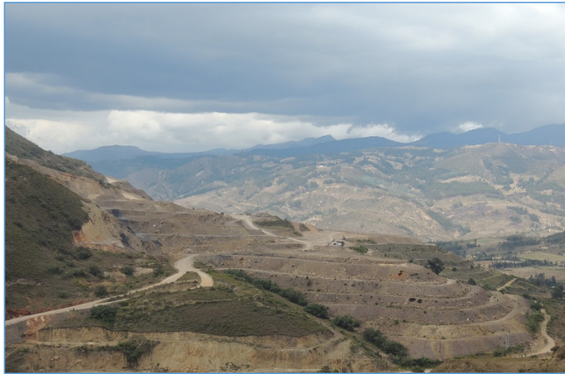
Fotografía No. 02: Panorámica explotación a cielo abierto de Calizas; Inspección a títulos mineros en Paz del Río - Boyacá
