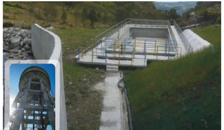
Proyecto MAVDT. Aprovechamiento quebrada Las Piedras para el acueducto de Pasto (Nariño).
