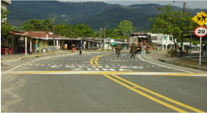
Carretera la Soberanía: Pavimentación Paso Nacional por Cubara
