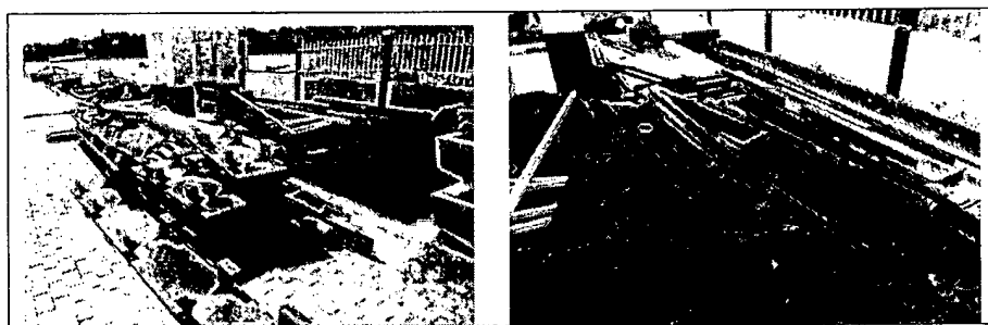
Elementos existentes en estación guardacostas San Andrés
