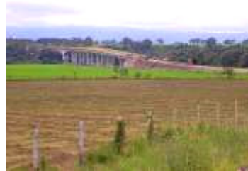
Panorámica del Puente viaducto y Terraplén
