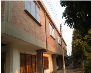
Detalles de fachada principal en mampostería a la vista
