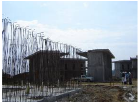
Construcción Centro Penitenciario. Jamundí - Valle
