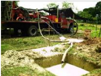
Aspecto del equipo de perforación del pozo profundo.
