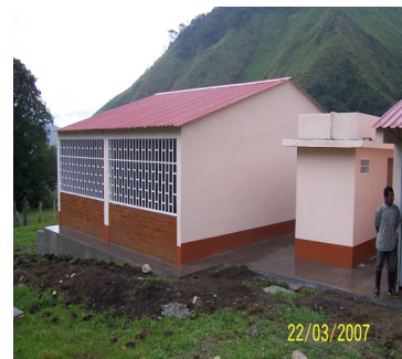
Fachada de Aula y Batería Sanitaria, construidas en este Proyecto.
