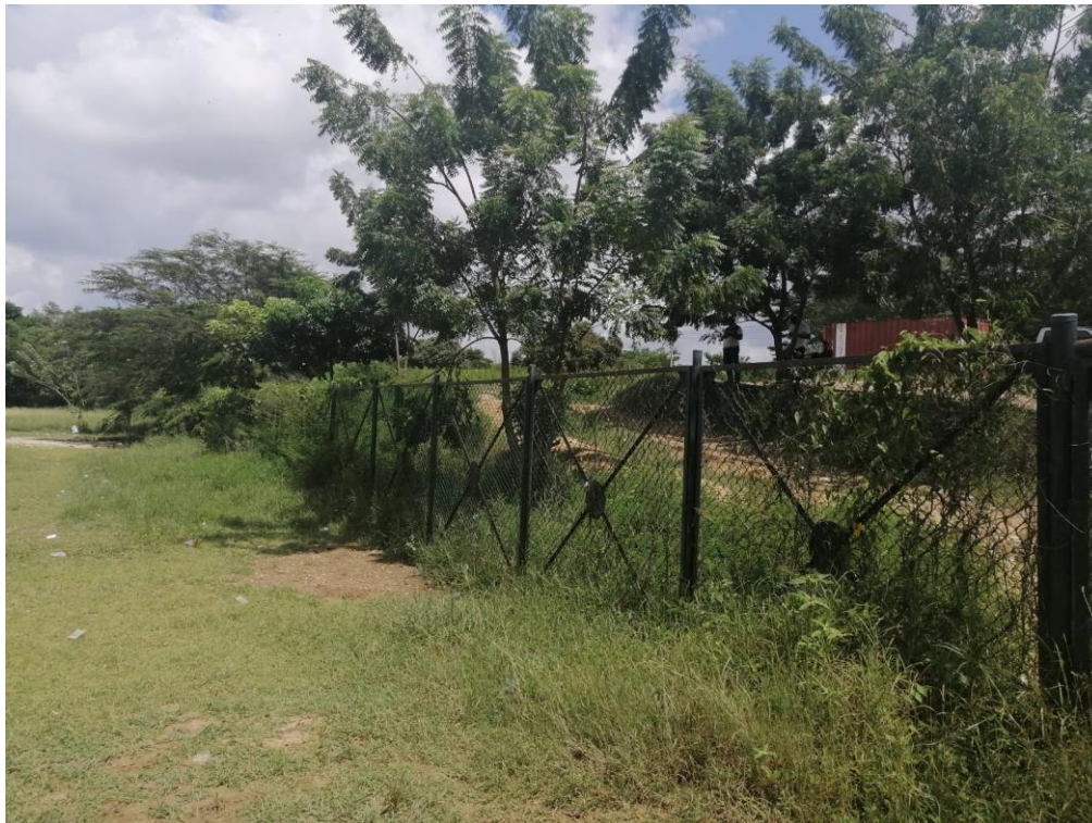
Foto No.5 Cerramiento cancha
