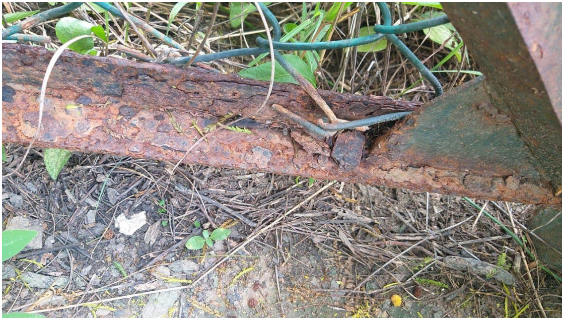
Foto No.9 Estructura de cerramiento en alto estado de corrosión
