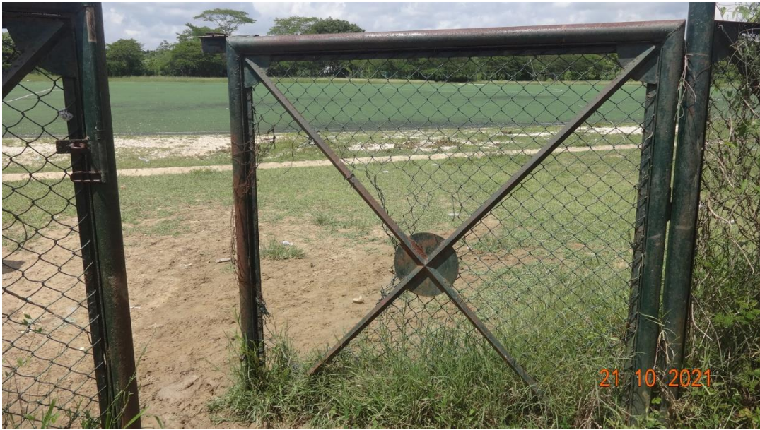
Foto No.10 Estado puerta de acceso al estadio.
