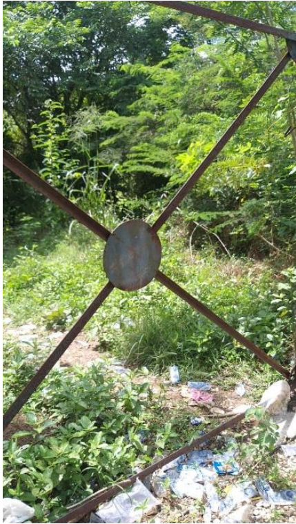
Foto No.12 Cerramiento Cancha
