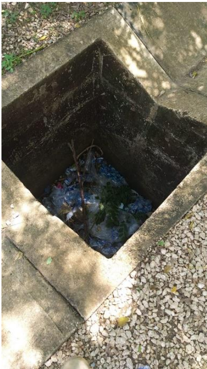
Foto No.14 Estado cajas de inspección (cunetas)
