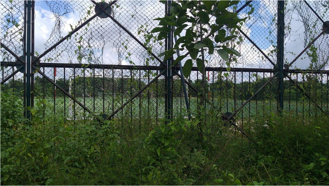
Foto No.8 Malla eslabonada deteriorada por falta de mantenimiento
