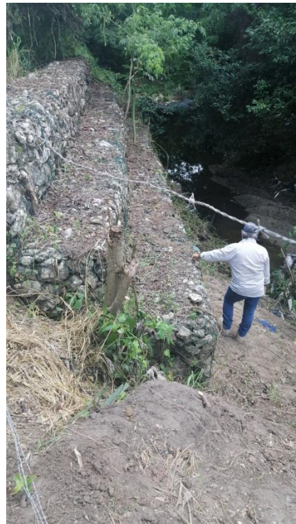
Foto No.18. Estado de gaviones (Obras de protección)
