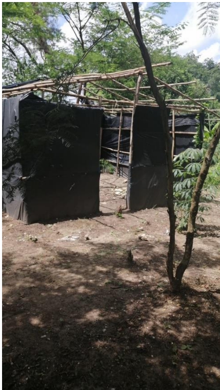
Foto No.17 Construcción de casas en el predio del estadio de futbol
