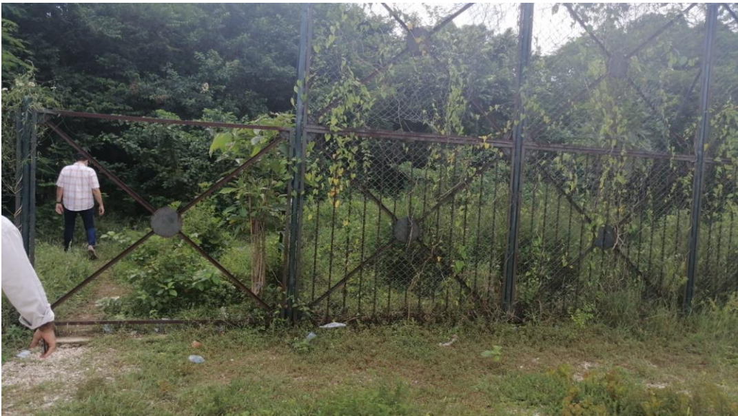
Foto No.7 Estado de la estructura del cerramiento de la cancha
