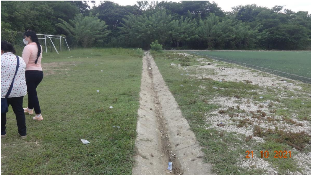
Foto No.4 Estado actual de cunetas perimetrales
