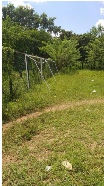
Foto No.15 Evidencia de falta de mantenimiento
