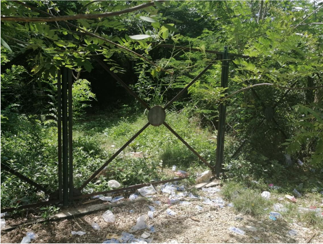
Foto No.6 Estado de la estructura del cerramiento de la cancha
