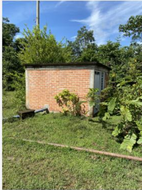
Caseta de bombas
