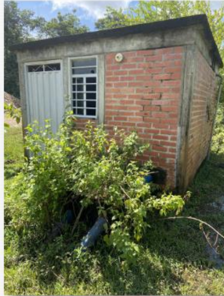
Caseta de bombas
