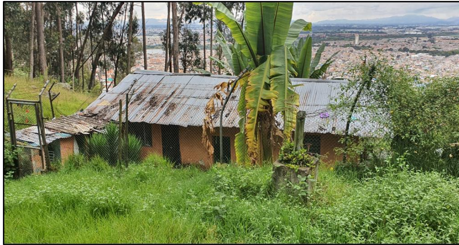
Imagen No. 8- Registro Fotográfico
