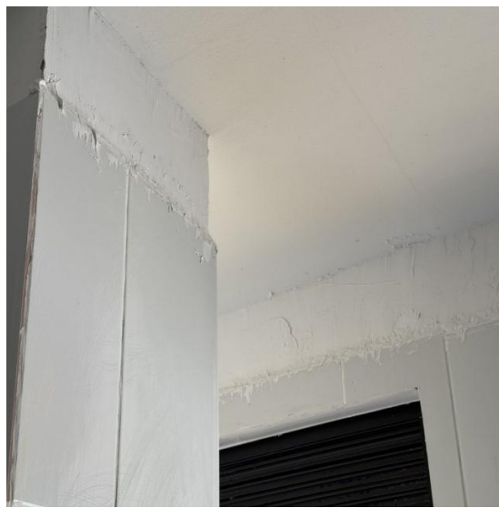
Imagen No. 6 Aplicación de boquilla enchape de pared
