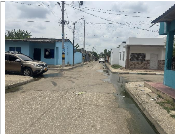
Imagen 7. Afectación ambiental por vertimiento de aguas servidas a la calle
