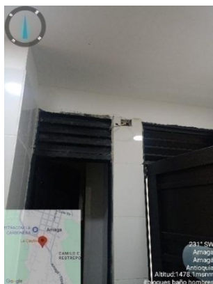
Imagen No. 15 Ornamentación con residuos de pañete y pintura
