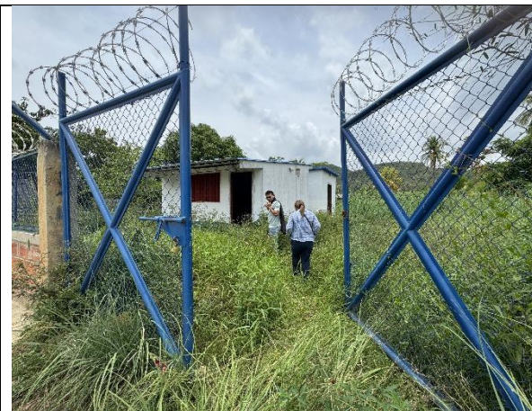
Imagen 1. Estado actual EBAR
