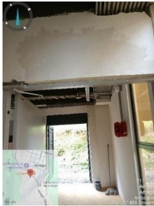
Imagen No. 19 Remates internos sin filos ni pintura
