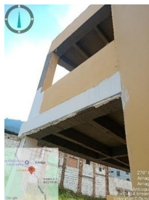
Imagen No. 18 Remates de fachada sin filos ni pintura
