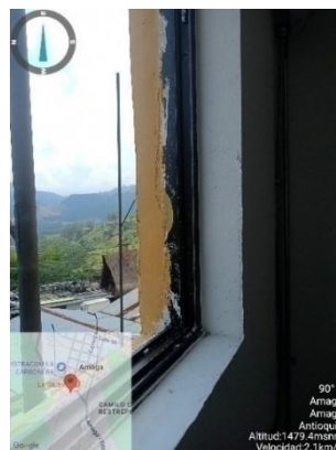
Imagen No. 16 Ornamentación con residuos de pañete y pintura
