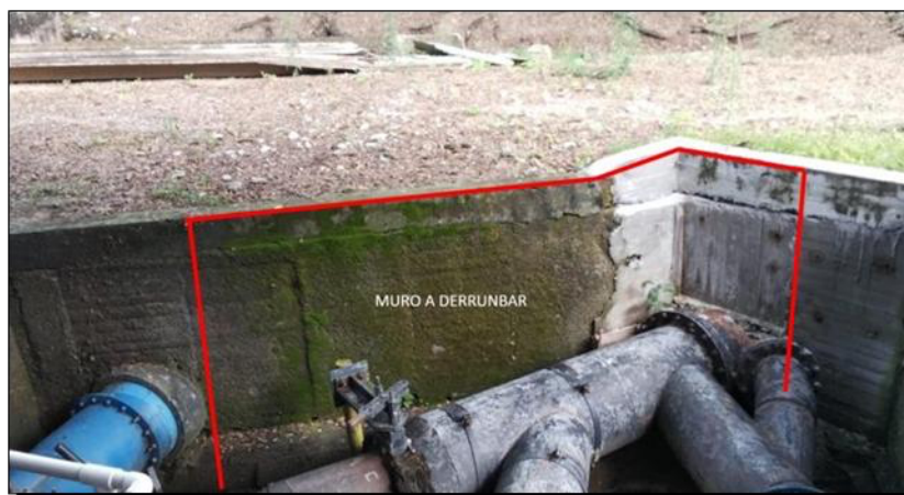
Ilustración 8. Ubicación Del Muro A Destruir En La Estación Segunda Etapa
