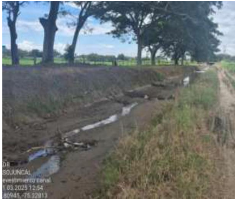
Ilustración 36. Canal Lateral N° 5.
