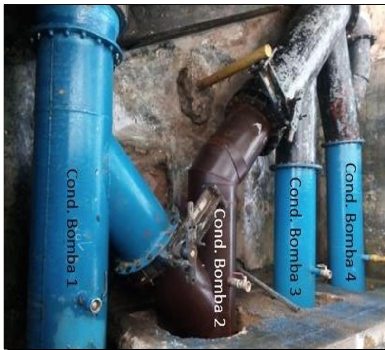
Ilustración 6. Conexión Existente en la Estación de Bombeo N° 2
