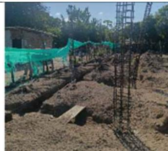
Vigas de cimentación inconclusas y con excavaciones expuestas
