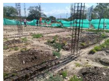
Acero de refuerzo en estado de oxidación
