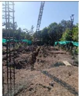
Acero de refuerzo para columnas expuesto a la intemperie y sin apoyos
