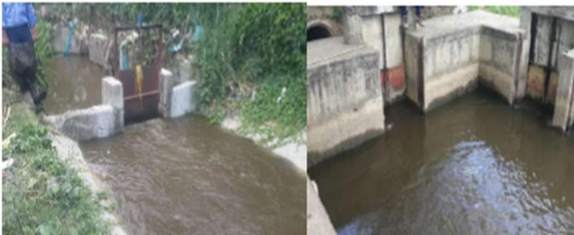
Insuficiencia parcial de equipos de medición de caudal en tomas prediales para facturación de volúmenes de agua suministrados y control de pérdidas de dotación por posibles crecientes durante la entrega del servicio.
