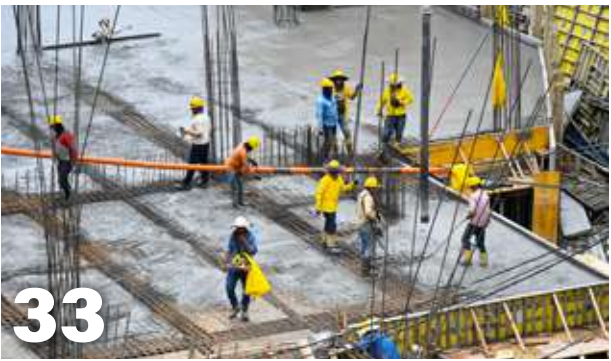
La Universidad Industrial de Santander y ENTerritorio S.A. avanzan en la construcción de la facultad de salud más moderna de Latinoamérica
