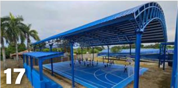
Un nuevo aire para la educación en Sincerín: finaliza la reposición y construcción de la Institución Educativa Técnica Agropecuaria
