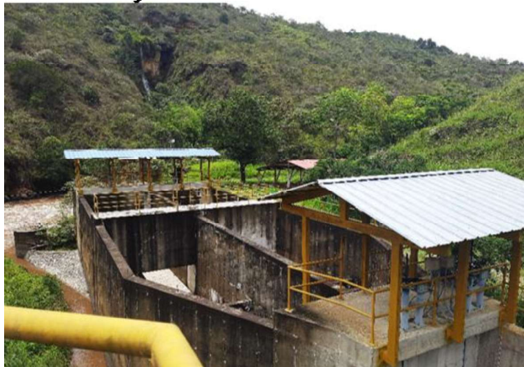
Figura. Vista del esclusor de sedimentos
