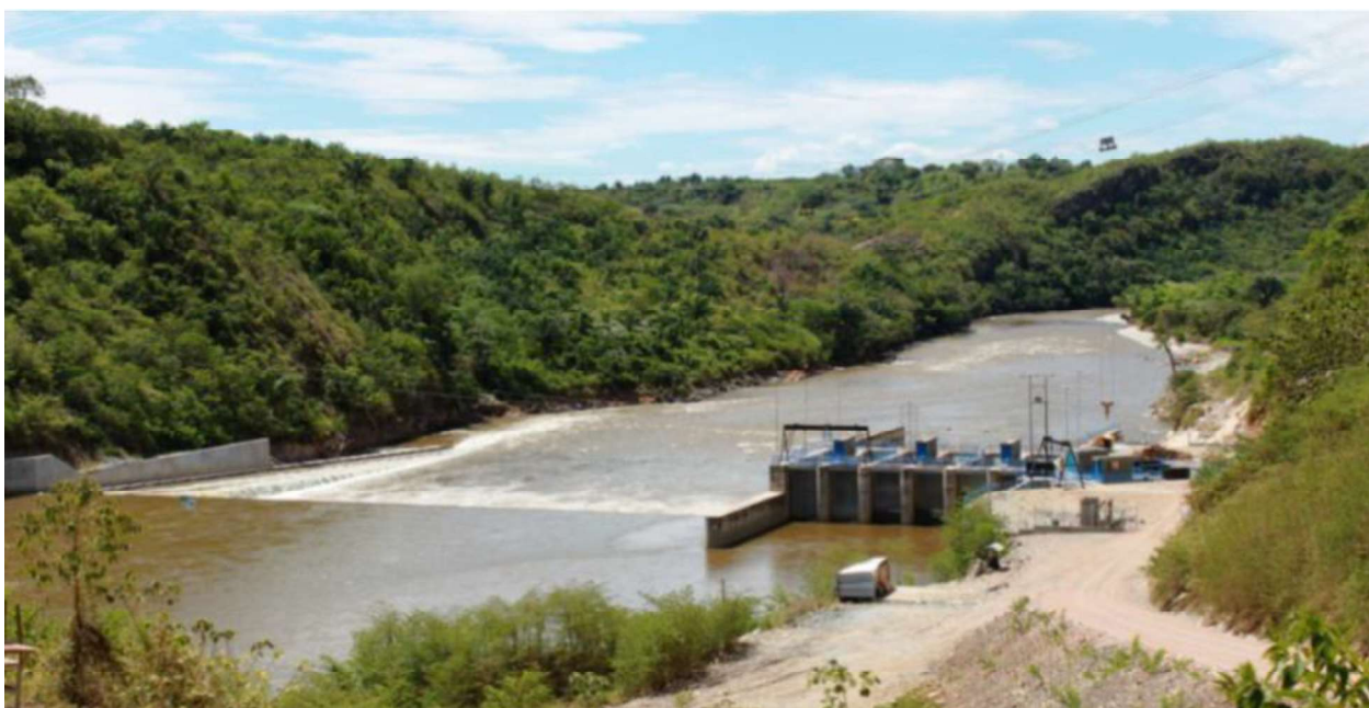
Figura. Vista de la entrada al túnel de aducción
