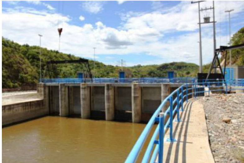
Figura. Vista del canal de limpieza y sus seis compuertas radiales
