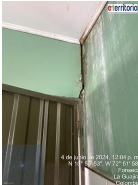
*Ilustración 93. Grietas en elementos estructurales en el P.S Maya Bangloma
