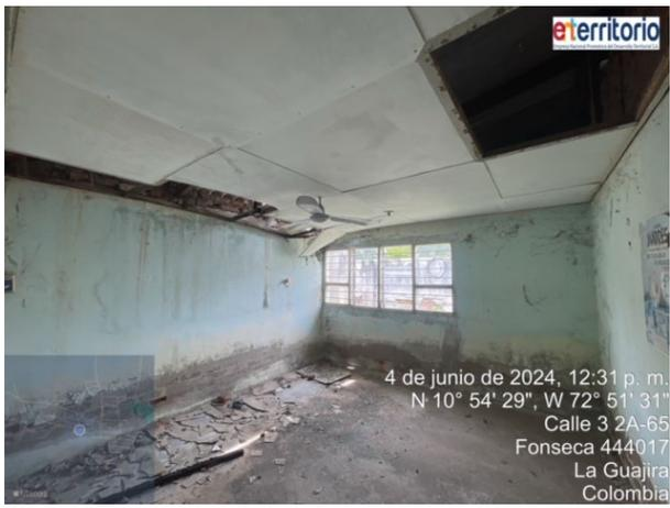
Ilustraciones 88 y 89. Mal estado del Bloque existente que justifica su Reposición.
