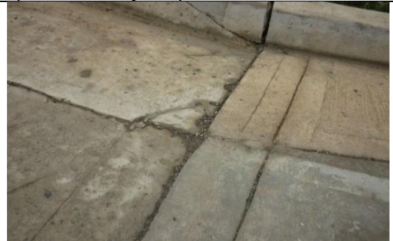
Grietas y fisuras transversales y de esquina en placa-huellas y rampas
