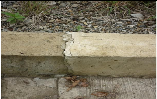
Grietas y fisuras transversales y de esquina en placa-huellas y rampas
