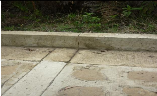
Grietas y fisuras transversales en cunetas - sardinel
