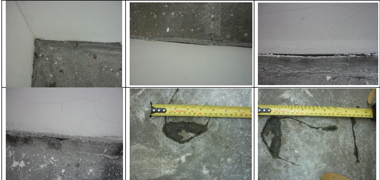
Fisuras y desprendimiento de sello de juntas en el cielo raso
