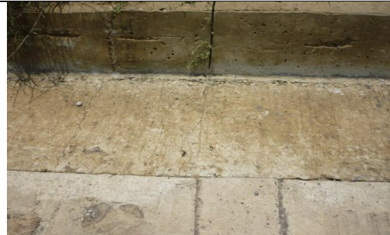
Grietas y fisuras transversales y de esquina en placa-huellas y rampas
