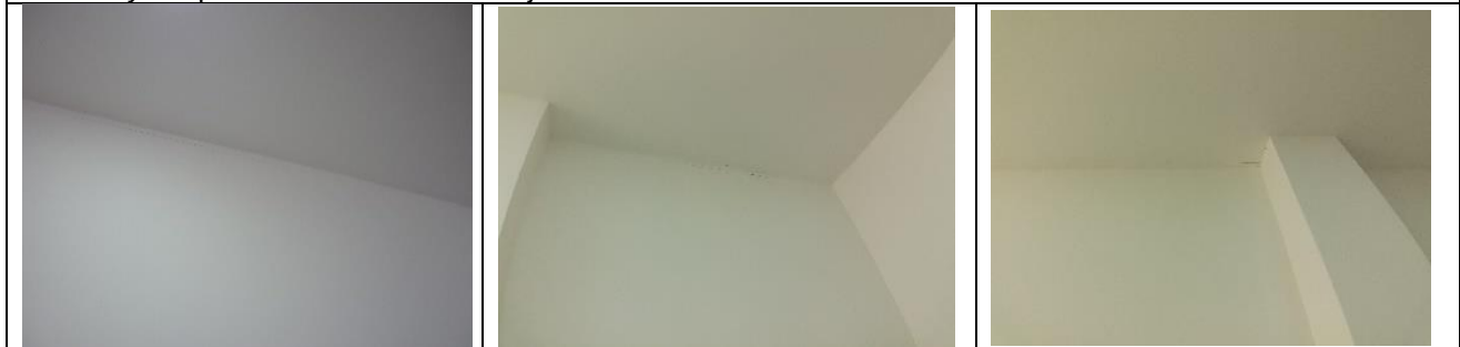
Fisuras y desprendimiento de sello de juntas en el cielo raso
