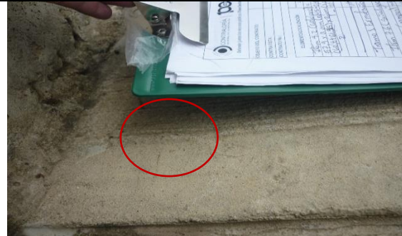
Profundidad de la lámina de agua en cunetas que no superan los 2 cm
