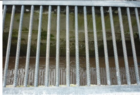
Oxidación en bancas y cerramiento en el área de juegos infantiles y platinas soporte de baranda
