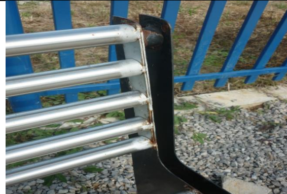
Oxidación en bancas y cerramiento en el área de juegos infantiles y platinas soporte de baranda
