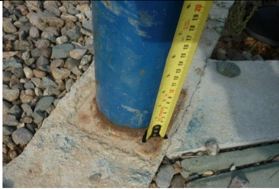
Oxidación en bancas y cerramiento en el área de juegos infantiles y platinas soporte de baranda
