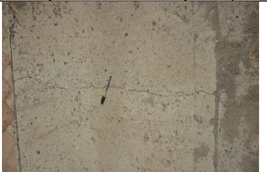
Grietas y fisuras transversales en vigas riostras
