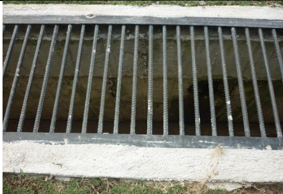
Oxidación en bancas y cerramiento en el área de juegos infantiles y platinas soporte de baranda
