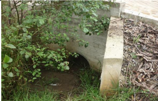
Obras de drenaje (alcantarillas) colmatadas
