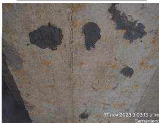
Imagen No. 01: Resane en fisuras con presencia de hormiguo y acero expuesto con epóxico en viga 4 A-D
