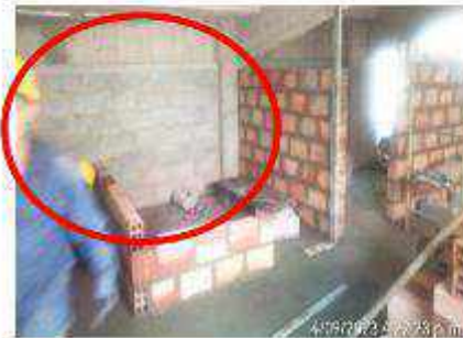
Imagen No. 04. Bloque estructural en el eje 4 A - D
