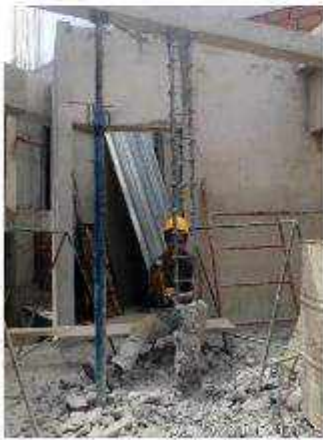
Imagen No. 02. Demolición y reconstrucción de Columneta de oficina, por Hormigueo y pérdida de material de concreto
