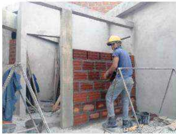
Imagen No. 02. Demolición y reconstrucción de Columneta de oficina, por Hormigueo y pérdida de material de concreto
