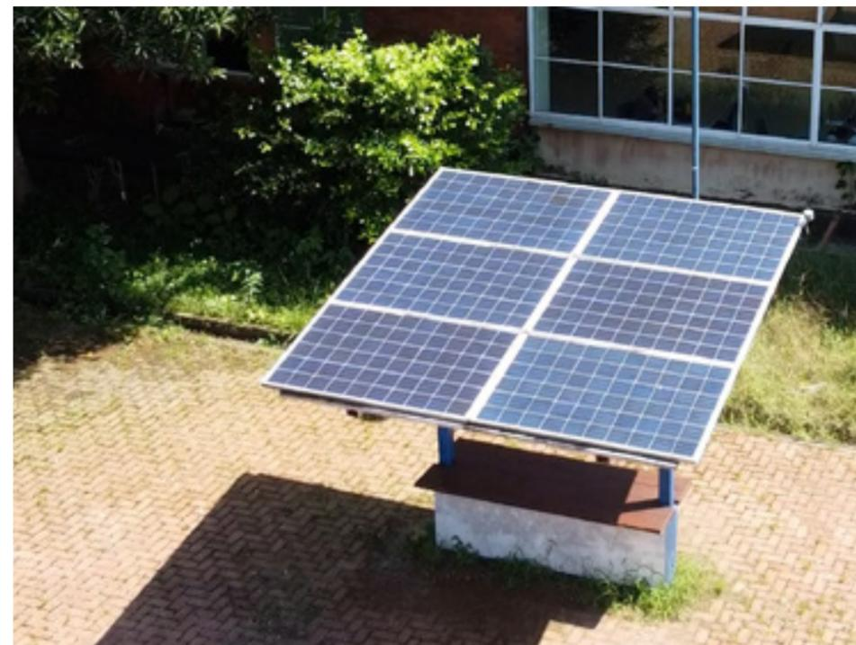
En este caso puntual, la adecuación para cada vivienda está compuesta por 2 módulos solares fotovoltaicos monocristalinos, cada uno de 395 vatios, que proveen 790 watio pico (potencia máxima que puede alcanzar cada instalación) y que alimentan 4 luminarias y 5 tomacorrientes.
