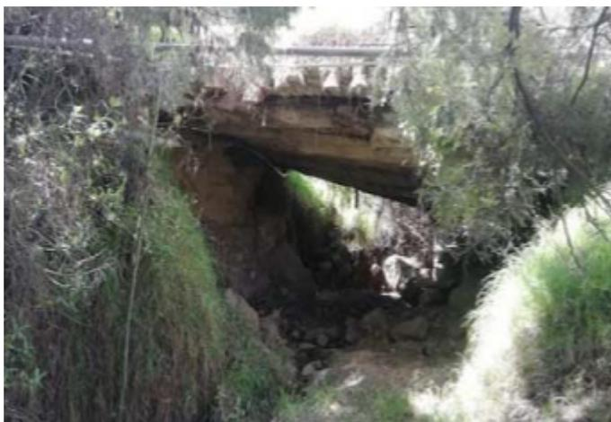
Foto: Estado anterior puente vehicular Quebrada Siatoca (madera y recebo común)
