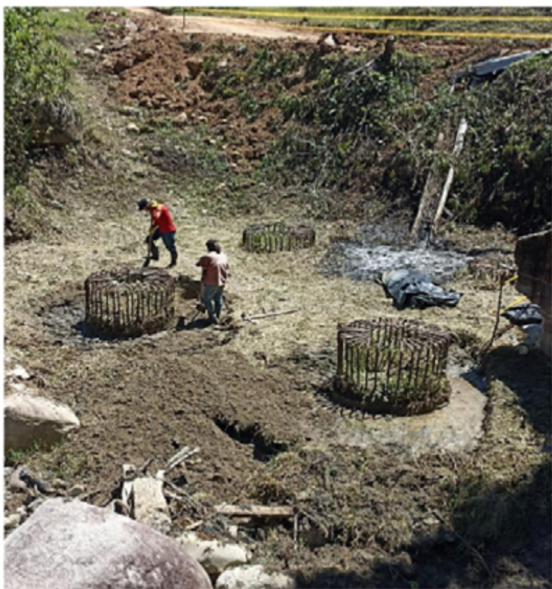
Foto: Avance de la obra: Excavación solado estribo izquierdo
