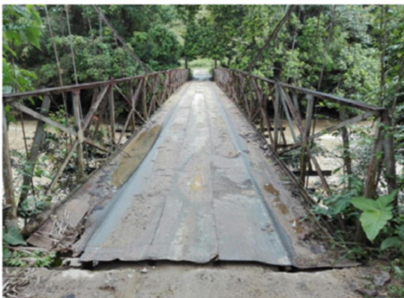
Foto: Puente vehicular sobre el Río Amoyá (sin intervención)
