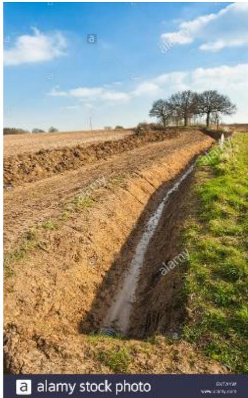
**Figura 70. Ejemplo de un drenaje para sacar el agua de la locación como etapa preliminar. Este drenaje debe estar en dirección al sentido de drenaje de la cuenca donde se instale la locación.**
