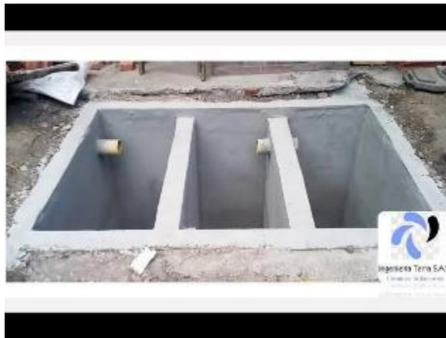
Figura 67. Trampa de grasas. Se utiliza para prevenir que fluidos hidrocarburos contaminen fuentes de agua del drenaje natural del pozo, y y porque se espera que durante la recuperación de núcleos, hidrocarburos y materia orgánica se liberen durante la preparación de la muestra. La trampa debe ser cubierta con una malla protectora para evitar caídas
