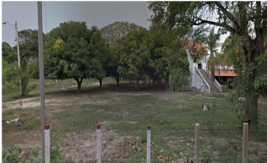
ILUSTRACIÓN 2. ESTADO ACTUAL DEL CENTRO, ÚNICAMENTE ESTA CONSTRUIDA CASA SANTA CRUZ.
