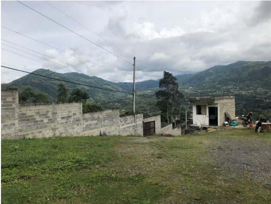
Como se puede evidenciar, las estructuras encontradas presentan un sistema de mampuesto simple y su función actualmente es de bodegaje temporal de maquinaria y equipos utilizados en la atención a emergencias. Asimismo, se una placa en concreto con zanja de aproximadamente 1 metro de ancho. Las anteriores estructuras no presentan funcionalidad alguna para suplir las necesidades del proyecto por lo que es necesario la demolición convencional.
