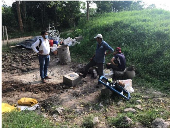
Figura 26: El pozo tiene una profundidad efectiva de 70,0 metros y se entubó en tubería de PVC RDE 21 de 6 pulgadas - CENTRO DE GESTIÓN Y DESARROLLO SOSTENIBLE SUR COLOMBIANO – PITALITO. Grupo 3
