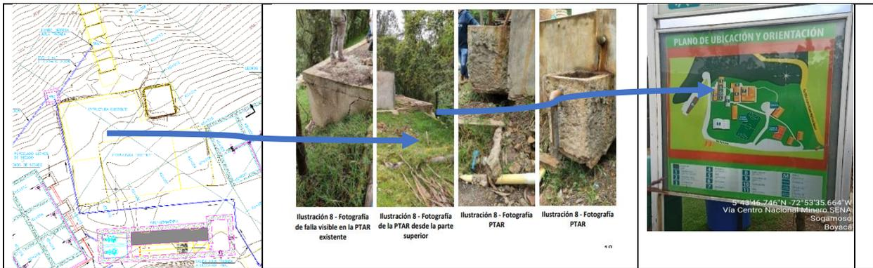
Figura 6.: PTAR INDUSTRIAL en deterioro existente ubicada cerca de la Mina. La Consultoría recomienda no demoler, por fallas de estabilidad en los terrenos adyacentes. CENTRO MINERO – Sogamoso – Boyacá. Grupo 1
