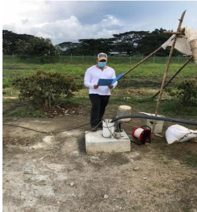
Figura 18: El pozo tiene una profundidad efectiva de 37,5 metros y se entubó en tubería de PVC RDE 21 de 6 pulgadas. CENTRO AGROPECUARIO DE BUGA- VALLE DEL CAUCA – CAB. Grupo 3
