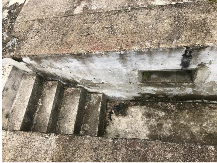
Figura 4. Zanja en plana de concreto con escalera
