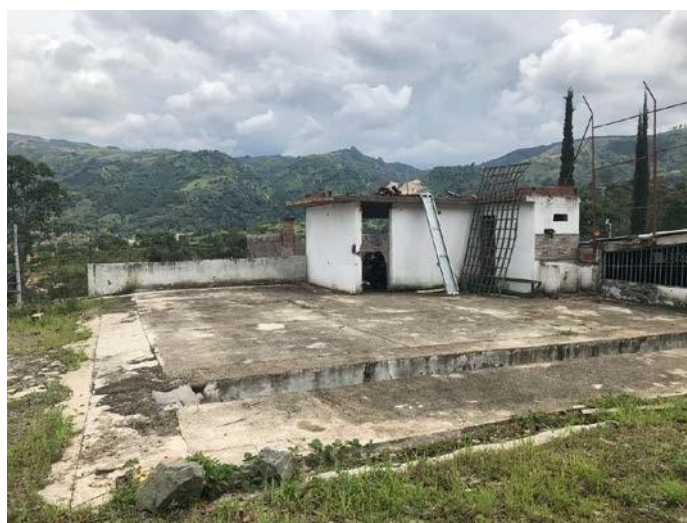
Figura 3. Placa en concreto existente con bloque en mampostería simple
