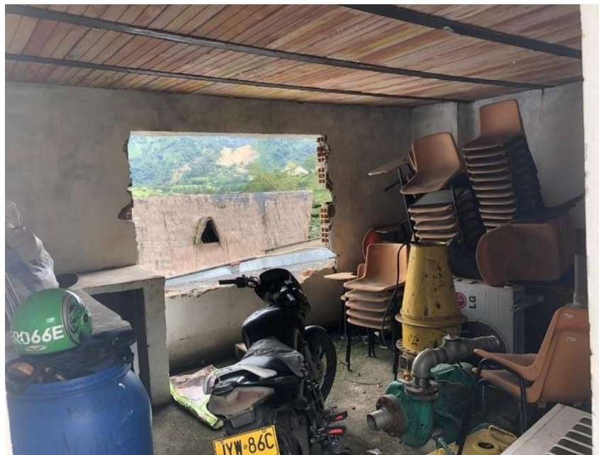
Figura 5. Interior bloque en mampostería simple
