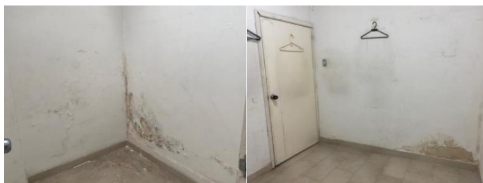
FIGURA 3 ESTADO GENERAL DE LOS PAÑETES DEL INMUEBLE. FOTOS TOMADAS EN EL ESPACIO 103 USADO COMO VESTIER DE LA VIGILANCIA.
