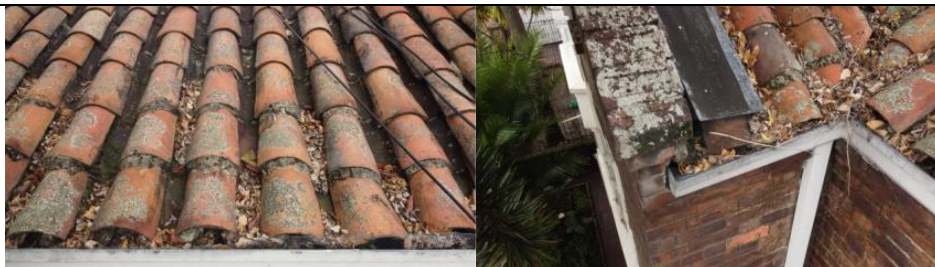
FIGURA 8 ESTADO ACTUAL DE LA CUBIERTA EN TEJA DE BARRO.
