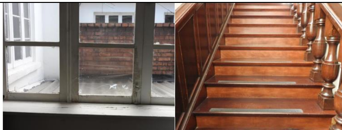
FIGURA 5 ESTADO ACTUAL DE CARPINTERÍAS DE MADERA.
