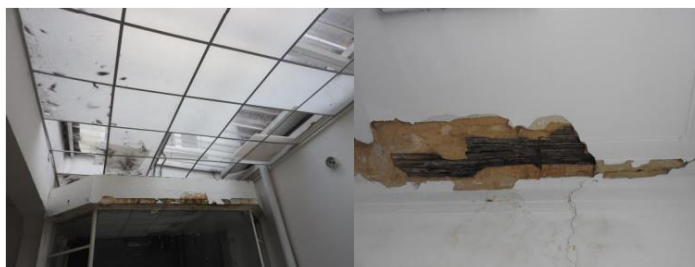
FIGURA 6 CIELORASO EN LÁMINA ACRÍLICA EN ESPACIO 115 USADO COMO AULA Y CIELORASO EN ESTERILLA DE GUADUA COLAPSADO. ESPACIO 202.
