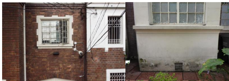
FIGURA 7 ESTADO ACTUAL DE LA FACHADA.
