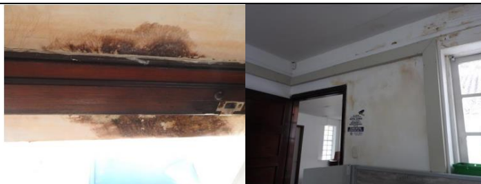
FIGURA 2 HUMEDAD PRESENTE EN MUROS INTERIORES ESPACIO 215 PARA USO DE OFICINAS.
