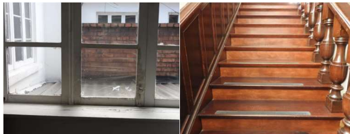
FIGURA 4 Estado actual de carpinterías de madera.
