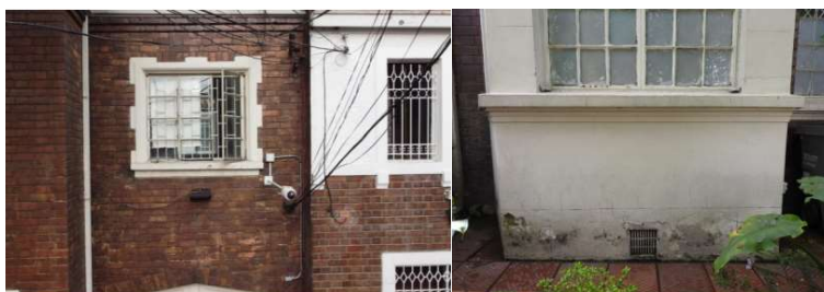
FIGURA 6 Estado actual de la fachada.
