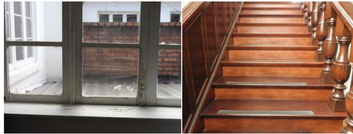
FIGURA 4 ESTADO ACTUAL DE CARPINTERÍAS DE MADERA.
