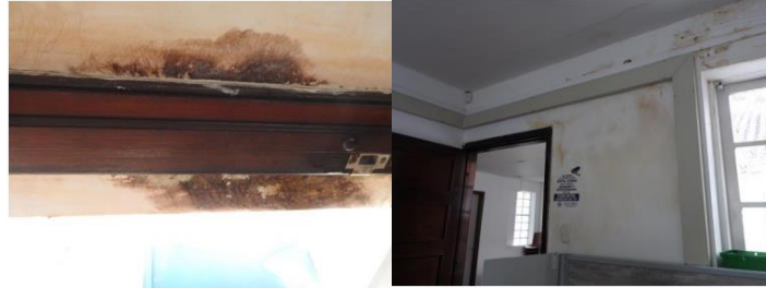
FIGURA 1 HUMEDAD PRESENTE EN MUROS INTERIORES ESPACIO 215 PARA USO DE OFICINAS.
