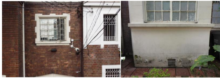
FIGURA 6 ESTADO ACTUAL DE LA FACHADA.
