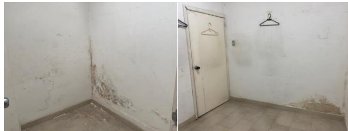
FIGURA 2 ESTADO GENERAL DE LOS PAÑETES DEL INMUEBLE. FOTOS TOMADAS EN EL ESPACIO 103 USADO COMO VESTIER DE LA VIGILANCIA.
