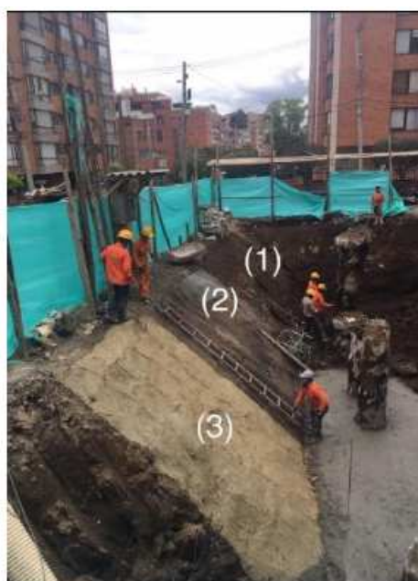
Figura 6.11 Estabilidad de Excavación Sin Soporte Edificio 1
