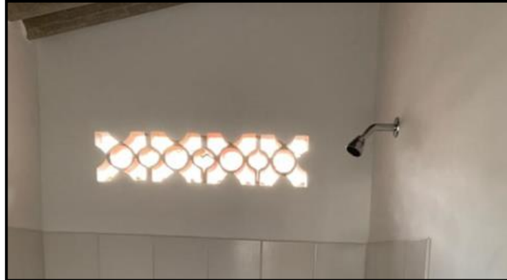
Ubicación calados en unidad sanitaria
