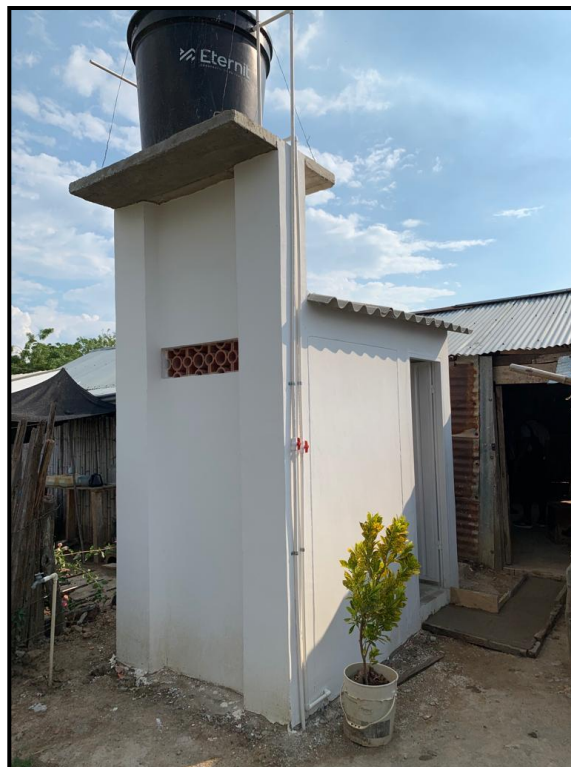
Imagen de instalación de Tanque aéreo
