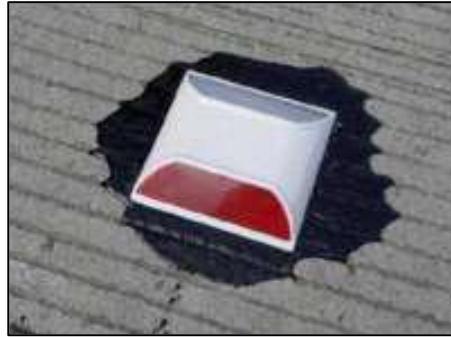
Gráfico 12. Forma correcta de instalación de Tachas Reflectivas
