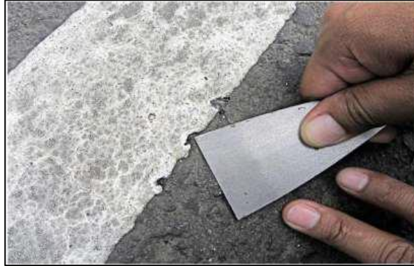
Gráfico 48. Prueba de adherencia de la resina termoplástica
