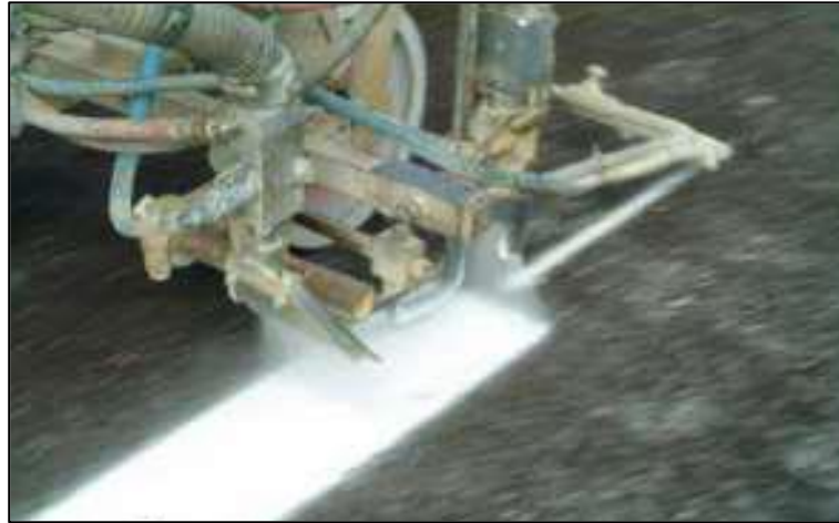
Gráfico 38. Aplicación con sistema de pulverización con aire (Neumática)
