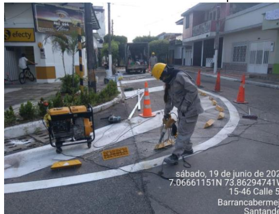
Gráfico 17. Instalación de bordillos traspasables
