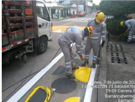
Gráfico 34. Aplicación de pintura spray para metros cuadrados
