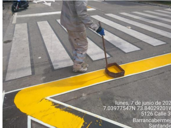
Gráfico 33. Plástico en frío de aplicación manual llana
