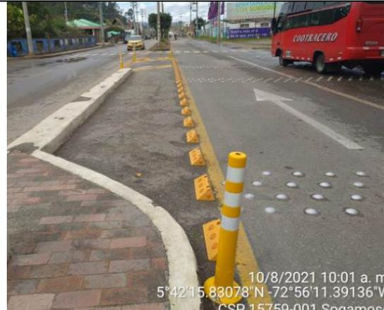
Fotografía N°4: Instalación de dispositivos en el punto 001- Zona 3-Sogamoso
