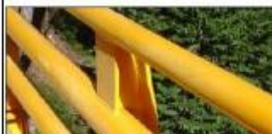
Para barandas vehiculares es de aplicación la norma colombiana de diseño de puentes CCP-14 (sección 13 - Barandas), la cual es de obligatorio cumplimiento a partir del 26 de enero de 2015 (resolución 0000108 del Ministerio de Transporte). Dicha norma aplica para puentes o viaductos nuevos y rehabilitados.
