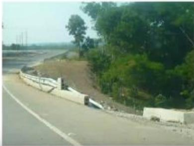
En este último ejemplo se evidencia la instalación de esta sobre un bordillo, en donde la altura de la defensa es muy poca, se recomienda el uso de separador el cual ayuda a disipar energía y garantiza después del bordillo con separador.
