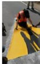
Para la instalación de esta marca se recomienda que no existan fisuras, ahuellamiento.
