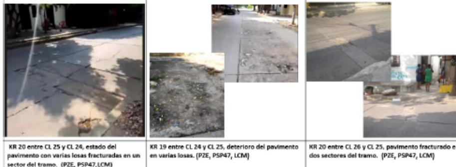
ENTerritorio explica los deterioros localizados de pavimento, en la imagen de la izquierda tenemos un fallo de una ruptura en varias losas fracturadas y con hundimiento en la KR 20 entre CL 25 y 24, también en la KR 19 entre CL 24 y 25 deterioro del pavimento en varias de las losas, incluso parecen verse unos recalces superficiales, y por último, la KR 20 entre CL 26 y 25 tiene
