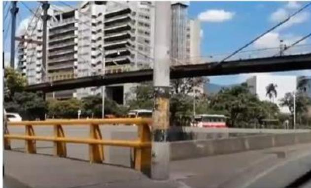
La posible solución a este tema se debe concentrar en que no se caída ningún vehículo en el deprimido, validar las alturas de la barrera con respecto al pavimento y se debería utilizar una barrera rígida. El riesgo para el motociclista siempre existirá. Adicionalmente se debe verificar la señalización en este tema incluyendo reductores de velocidad.
