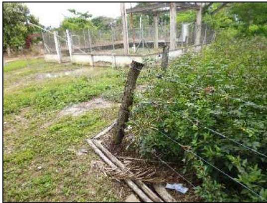
Fotografía 9 Espacio del acueducto
