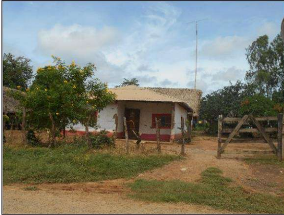
Fotografía 4 Vivienda Los Andes
