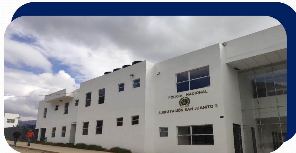
Ilustración 3 Subestación de Policía San Juanito II
