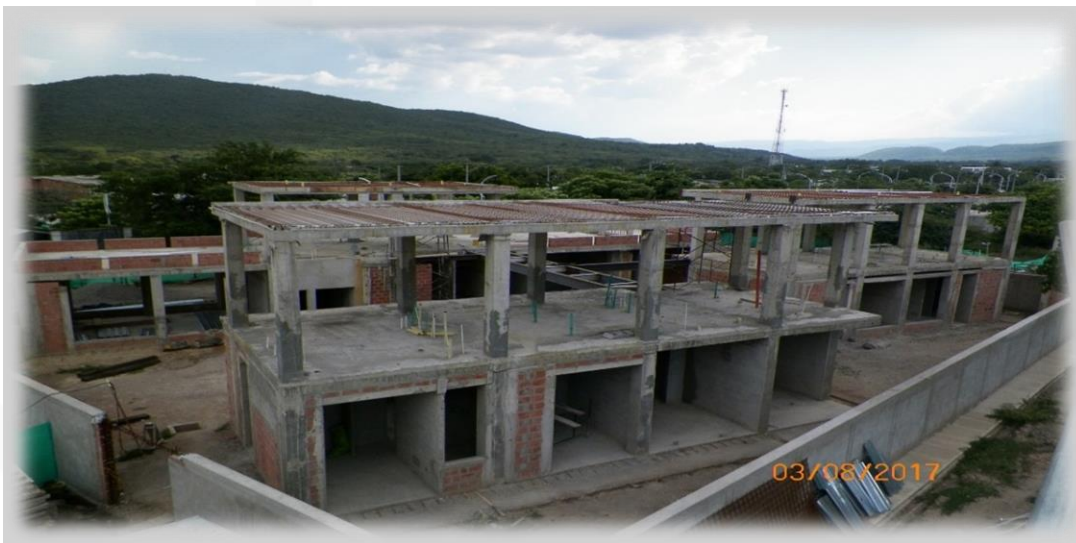
Estado actual de la Construcción Estación de Policía de Hatonuevo
