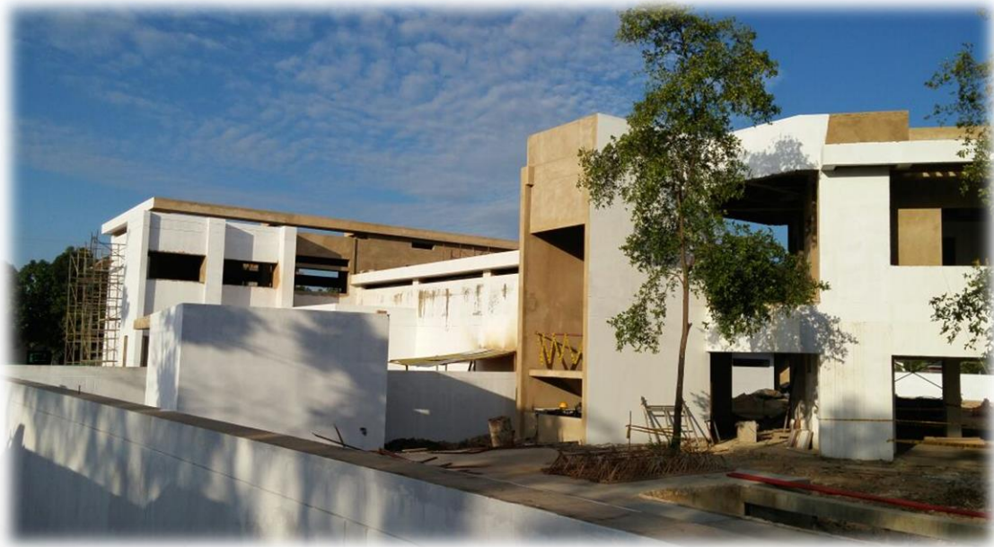
Estado actual de la Construcción Estación de Policía de Villanueva
