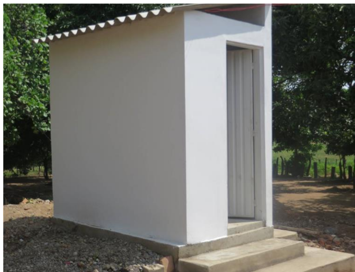
Proyecto ejecutado en el Municipio de Valledupar, departamento de Cesar.
