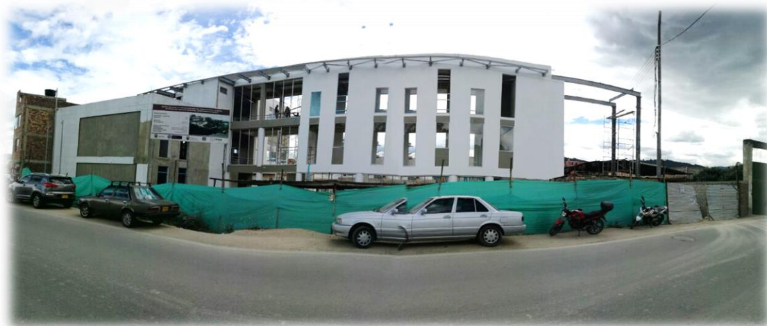
Estado actual de la Construcción Estación de Policía de Duitama
