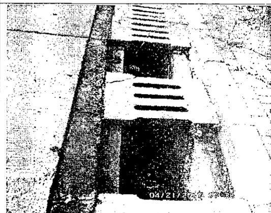
Foto No. 9 Deterioro de la tapa de la cuneta
