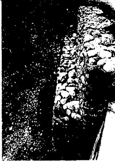
Detalle muro Gavión con base erodada y socavada. Sin soporte.
