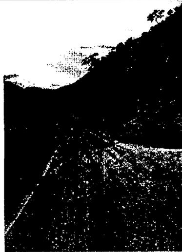
Derrumbe de talud. Material sobre el terreno que restringe la circulación.
