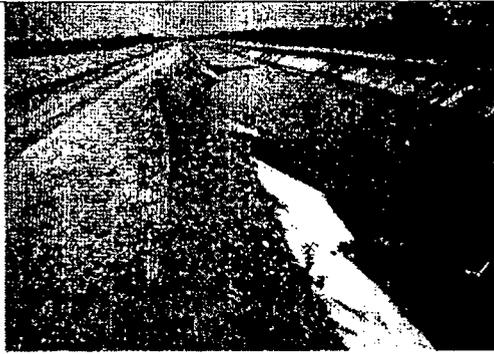
Perdida de banca y perfilado del canal.
